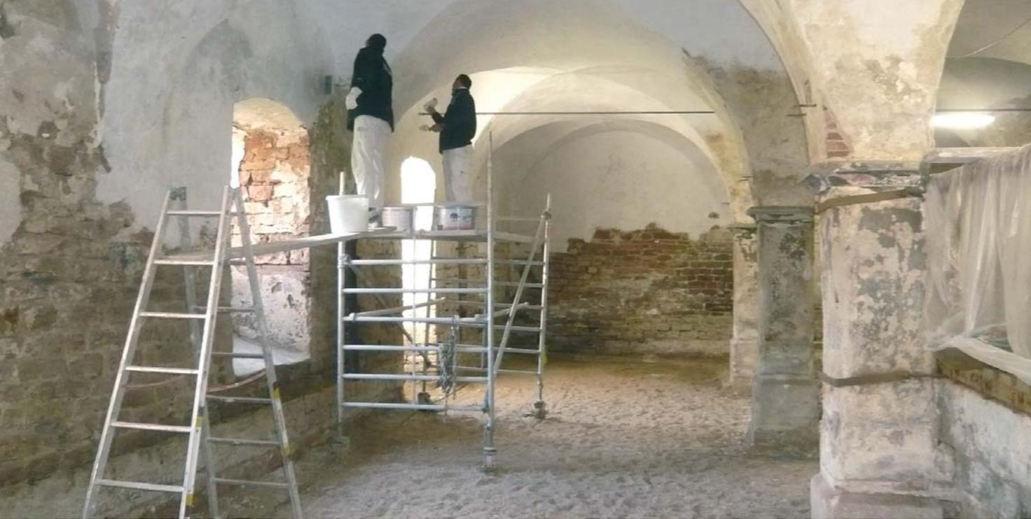
Während der Bauarbeiten: Sicherung und sorgfältige Erneuerung des Altputzes (oben), Glasschaumschotter als Dämmung des Heizestriches (unten).
