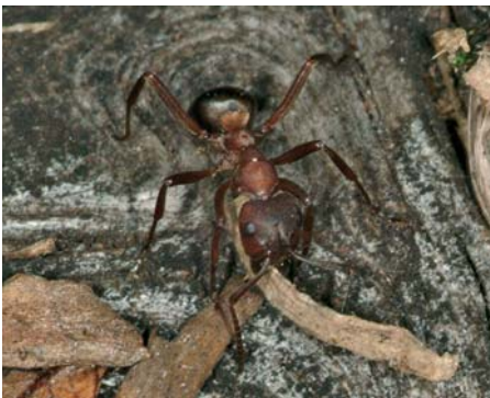
Nachdem das Holz von Käfern mit Gängen durchzogen wurde, können Ameisen eindringen und sich Nistbereiche ausnagen.
