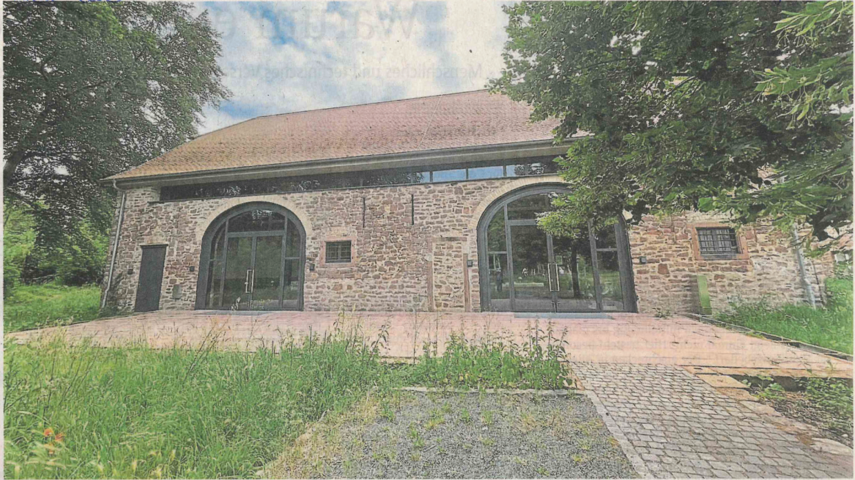
Der denkmalgeschützte Schafstall auf dem Kühkopf hat das jüngste Hochwasser gut überstanden. Er steht noch etwas höher als das Hofgut, das bereits wie eine kleine Hallig wirkt. Foto: Marion Menrath
